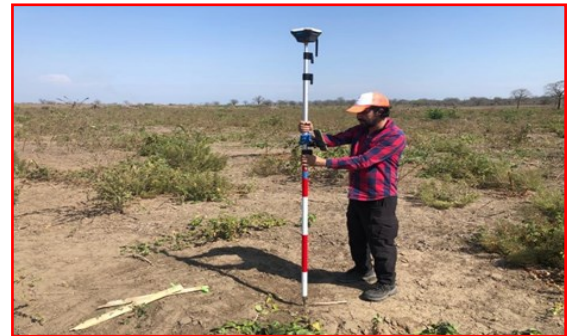
Figura 3. Replanteo en campo de drenajes primarios
